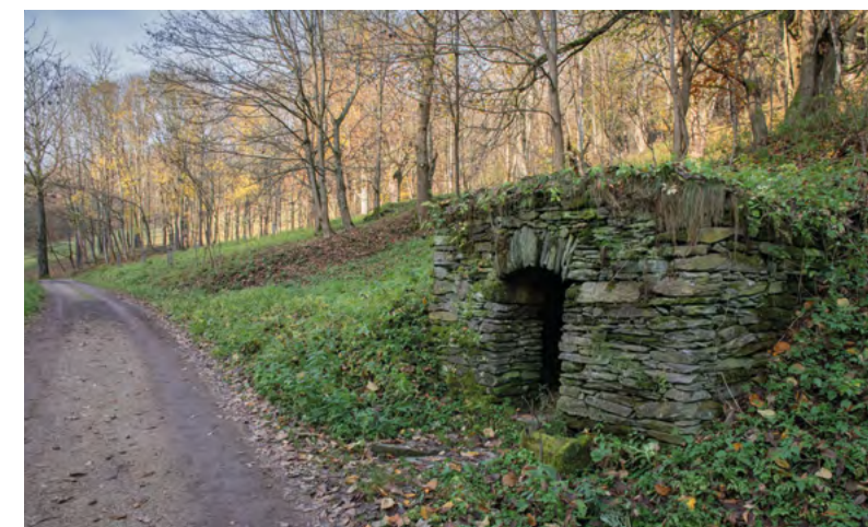
Opravená přírodní chladírna s protékající vodou tzv. mlíčnice. V této se ovšem chladilo hlavně pivo, patřila totiž k hostinci Johanna Tama, č.p. 1.
