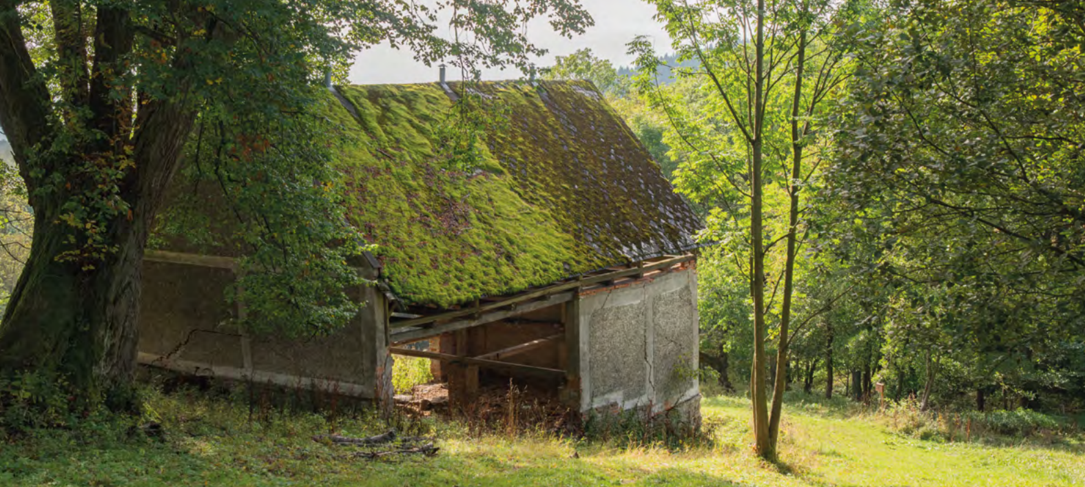
Stodola, která patřila k hospodářství Gustava Fucknera, č.p. 49, je jedinou stavbou, která ještě stojí
