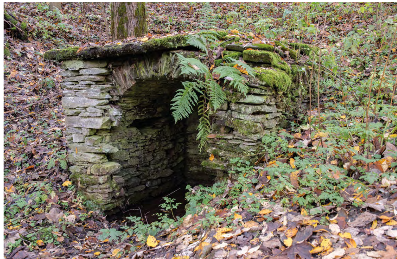
Jako studánka upravené ústí zavalené dědičné štoly Klinge. Neustále vytékající voda dává tušit, že za závalem budou ostatní podzemní prostory nejspíše neporušené.
