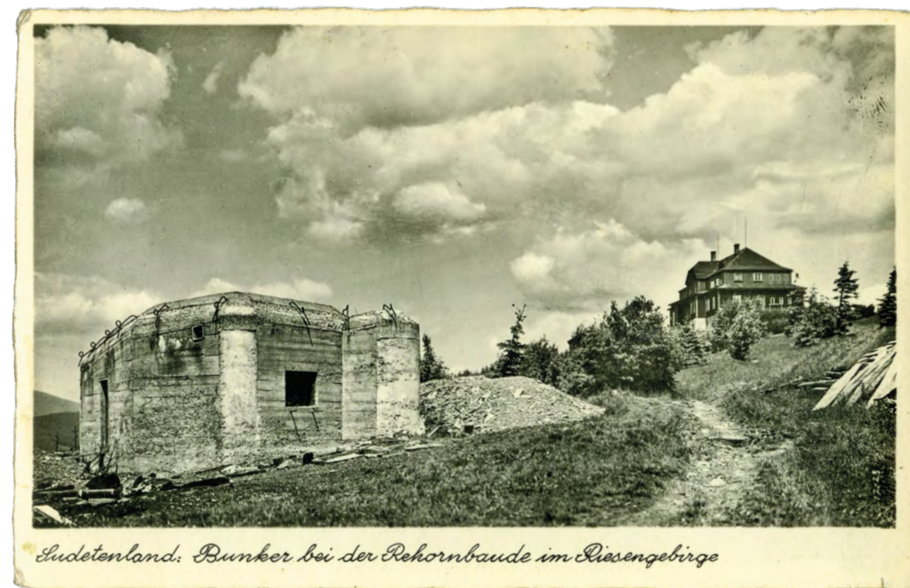
Netradiční pohled na Rýchorskou boudu od jihu s objektem lehkého opevnění Z1/26/A-140, archiv Městského muzea v Žacléři
