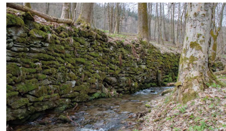
Regulace, která zabraňovala odnosu půdy ze svahů pravého břehu Zlatého potoka. Na sucho rovnané opěrné zdi vydržely na některých místech dodnes.
